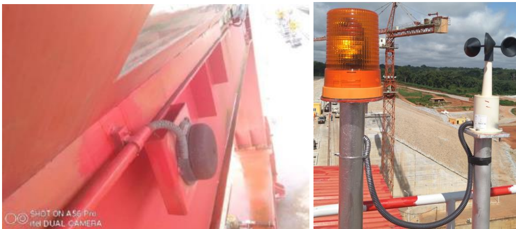
Figure 18 : Vue des avertisseurs sonore et optique
