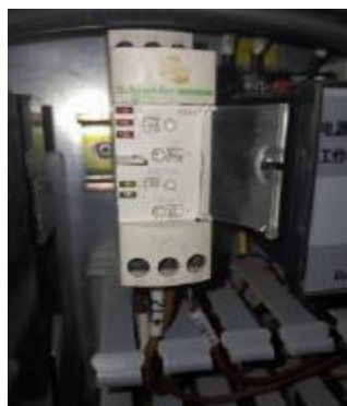
Figure 19 : Vue d'un relais de séquence de phase
